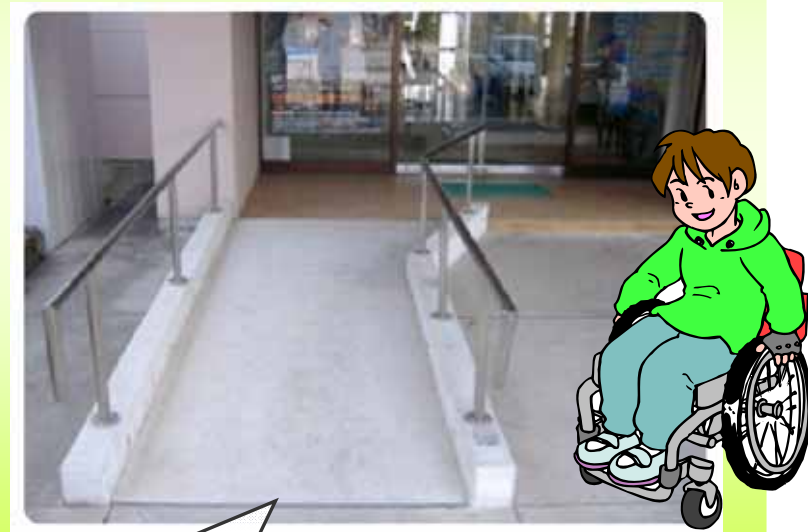
スロープの設置
