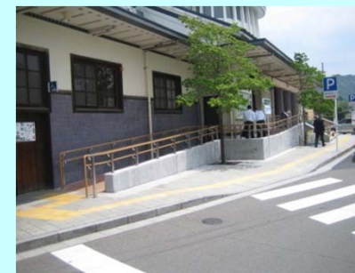
スロープ・2段手すり
