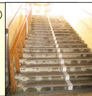
現況写真(肥前鹿島駅) 地下通路～ホーム間の階段
