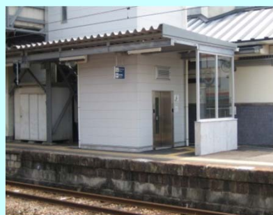
ホームに設置されたエレベーター
