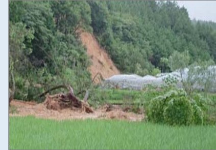
ハウレンソウハウス一部倒壊(富士町)
